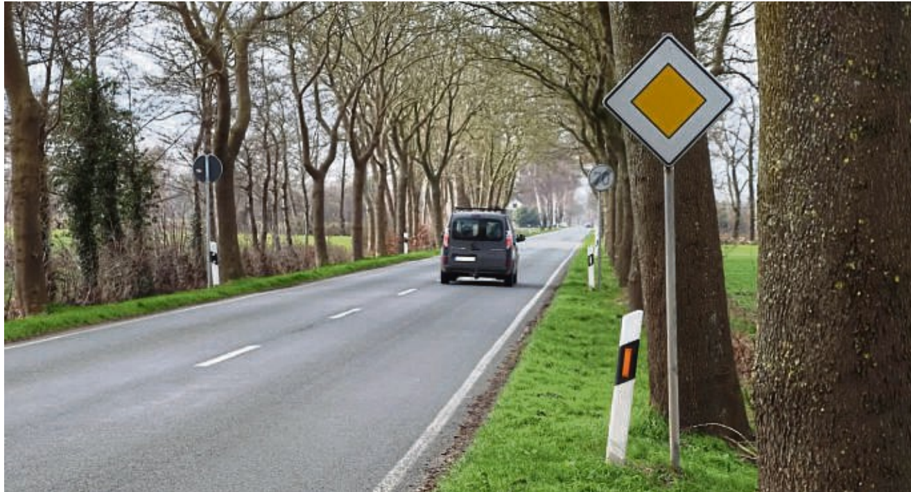
Ein Radweg soll laut Prioritätenliste des Landes zwischen Felde und Okel gebaut werden. Wann auch immer. FOTO: PK
