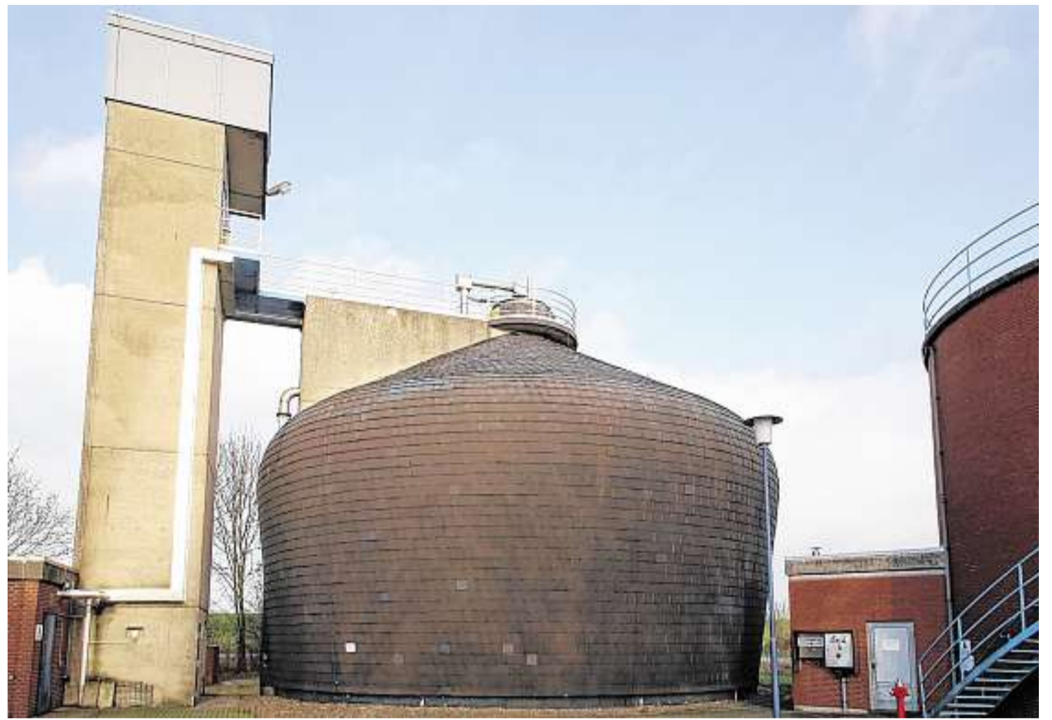
Der Faulturm des Eißeler Klärwerks wird im kommenden Jahr einer Inspektion unterzogen. Es gilt zu prüfen, ob der 1975 errichtete Turm saniert werden muss. FOTO: FOCKE STRANGMANN
