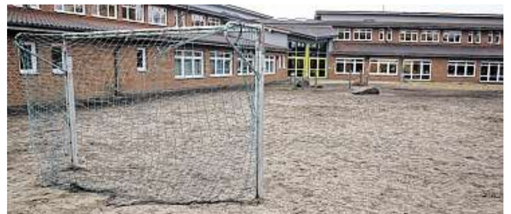
Der zur Sanierung vorgesehene hintere Schulhof der Grundschule in Langwedel wirkt momentan eher trostlos. FOTO: FOCKE STRANGMANN
