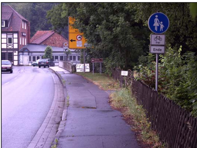
Ungünstig ausgebildetes Ende der Seitenraumführung für den Radverkehr
