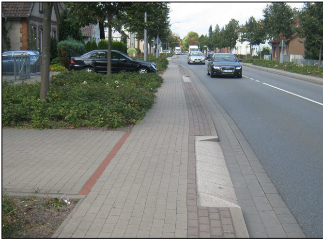
Bild 9: Baulicher Radweg mit Radwegüberfahrten und Rampensteinen
