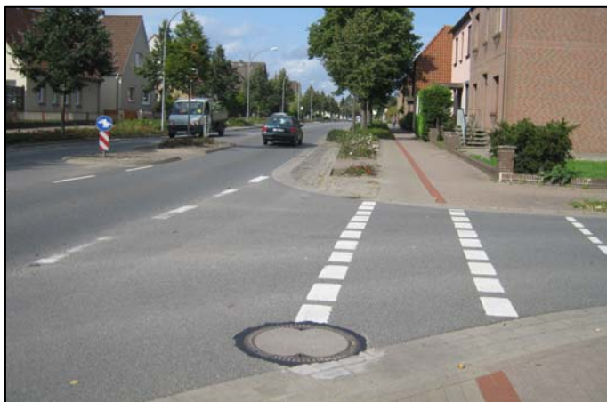
Radweg mit Furtmarkierung über Einmündung
