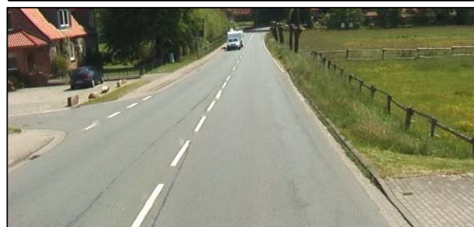
Ortsdurchfahrt mit schmalen einseitigen Gehweg
