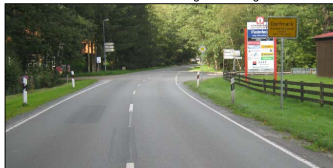
Beginn der Ortsdurchfahrt zunächst ohne Gehweg
