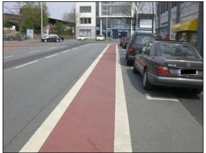
Bild 10: Radfahrstreifen in einer Ortsdurchfahrt neben Längsparkständen
