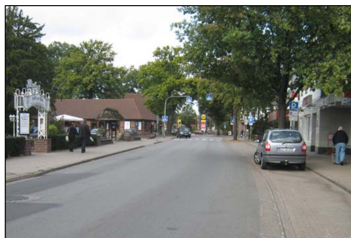
Zustand der Ortsdurchfahrt vor dem Umbau
